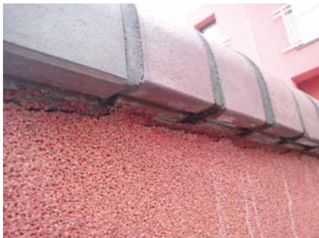
Zdjęcie 3 – Brązowy kolor tynku eksponuje biel wykwitów
