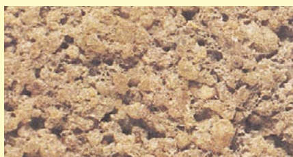
Zdjęcie 9. Tekstura zaprawy cementowej z domieszką napowietrzającą
