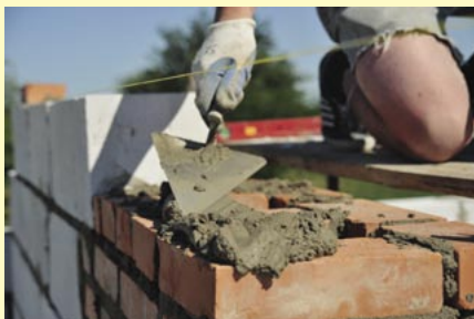
Zdjęcie 2. Do murowania powinno stosować się najslabsze zaprawy cementowo-wapienne przewidziane przez projektanta budynku
