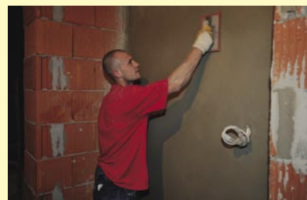
Zdjęcie 7. Odpowiednia obróbka powierzchni pozwala uzyskać gładkie powierzchnie tynków wapienno-cementowych.
