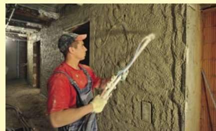
Zdjęcie 6. Tynki wapienno-cementowe. Zastosowanie agregatu tynkarskiego znacznie przyspiesza prace wykończeniowe
