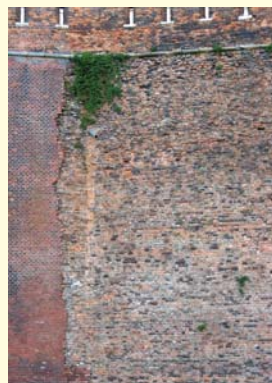
Fot. 2. Ten sam fragment muru przed renowacją
