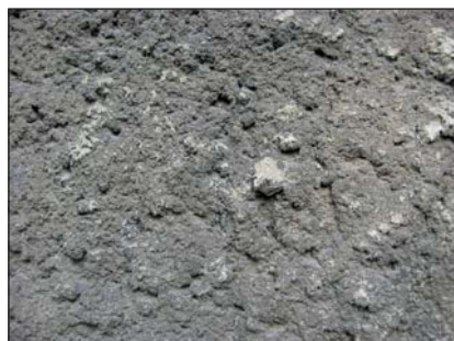
Zdjęcie 3. Struktura 70-letniego grubowarstwowego tynku wapiennego. Brak widocznych uszkodzeń.
