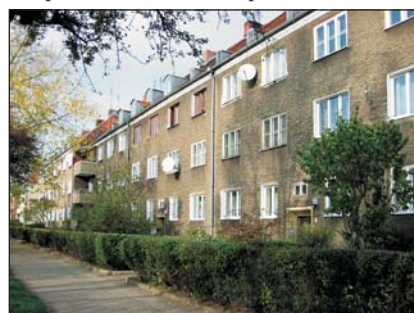
Zdjęcie 2. Elewacja wykonana w tynku wapiennym (lata 30-te).
