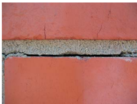
Zdjęcie 1. Nieprzepuszczalna, mrozoodporna zaprawa nie oznacza wodoszczelnego, mrozoodpornego muru (Zaprawa bez wapna).
